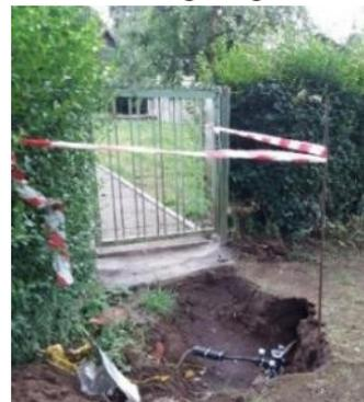
Da vermutlich in allen Abzweigungen Feuchtigkeit eingedrungen ist, freuen wir uns nun auf die neue Verlegung der Kabel. Der gesamte Weg B3 ab dem Hauptzähler muss aufgegraben werden. Da auch die Wasserleitungen den Weg kreuzen, ist vorsichtige Handarbeit angesagt, damit die Wasserleitungen nicht durch einen Bagger beschädigt werden.
